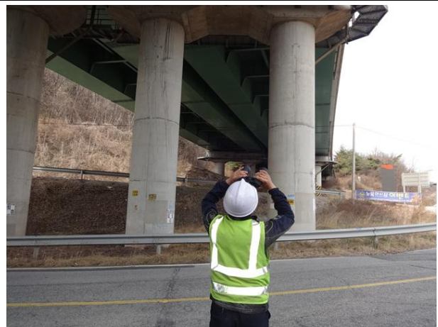
망원경을 이용한 외관조사
