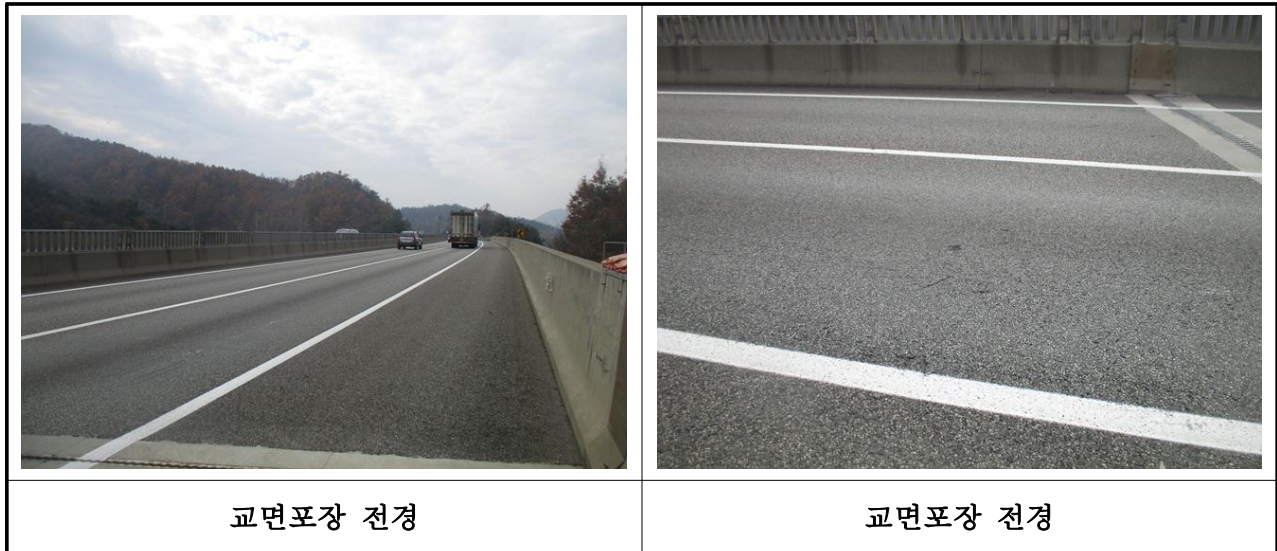
【사진 3.37】 교면포장 전경
