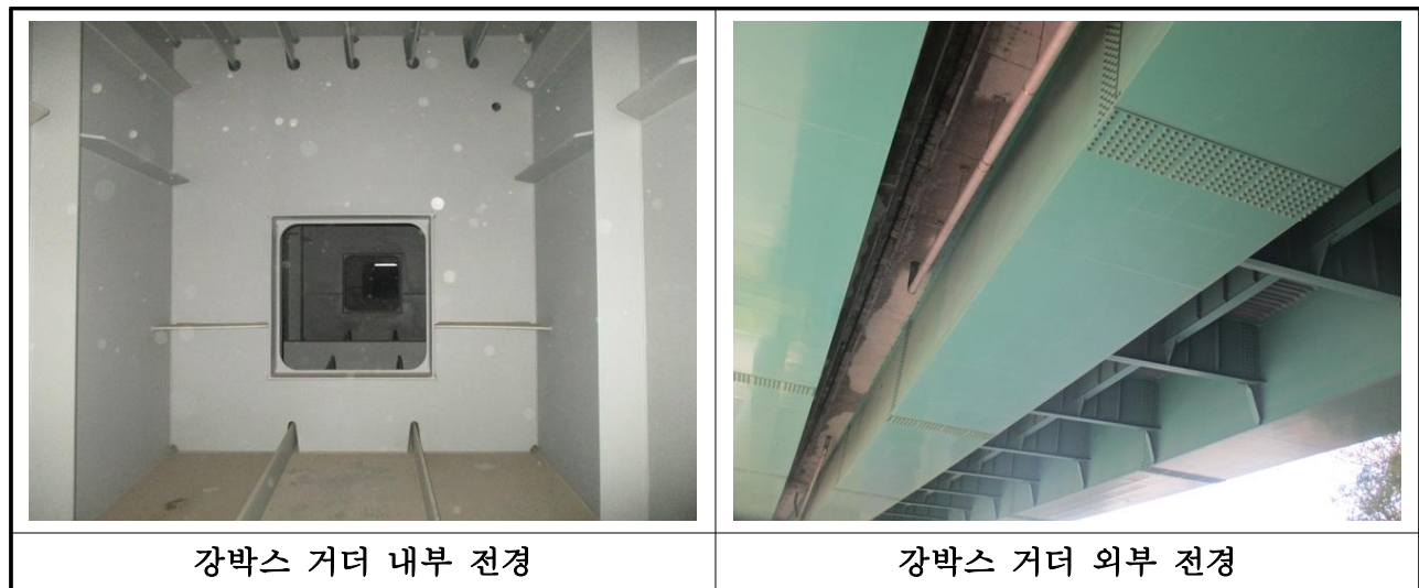
【사진 3.4】 강박스 거더 전경
