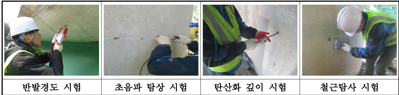
【사진 3.42】 콘크리트 내구성조사 전경
