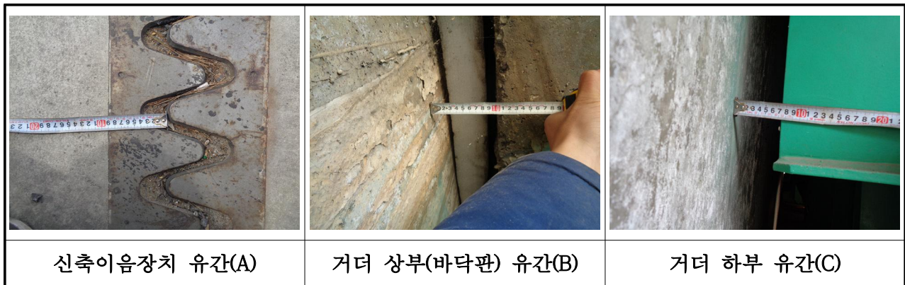
【사진 3.16】 신축이음 유간 측정방법
