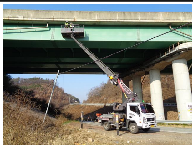
고소작업차를 이용한 외관조사
