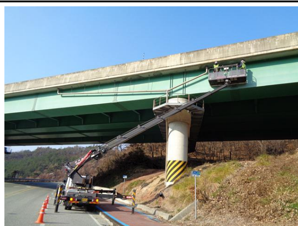
고소작업차를 이용한 외관조사
