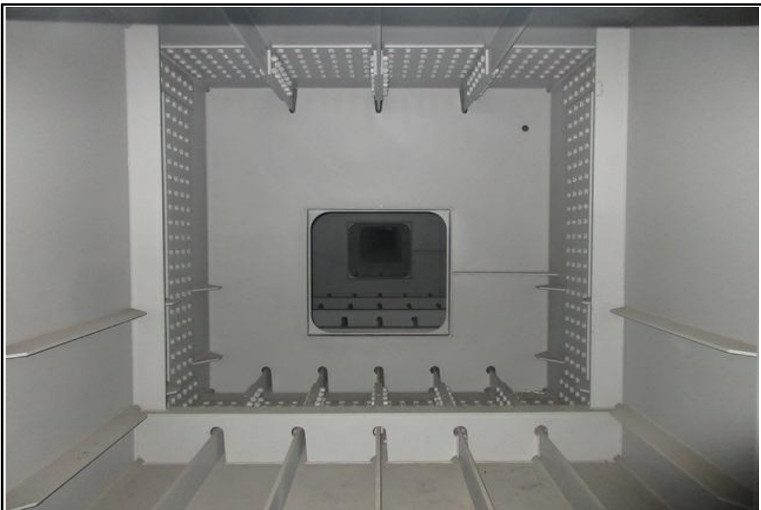
강박스 내부 전경
