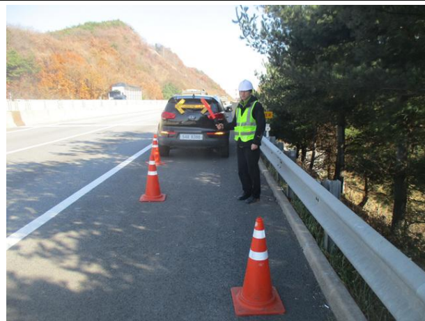
교통통제 후 교면포장, 난간 및 울타리 조사
