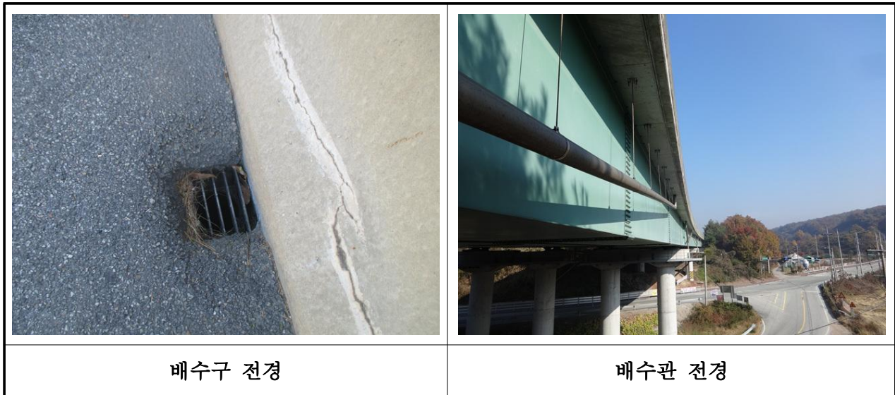
【사진 3.19】 배수구 및 배수관 전경
