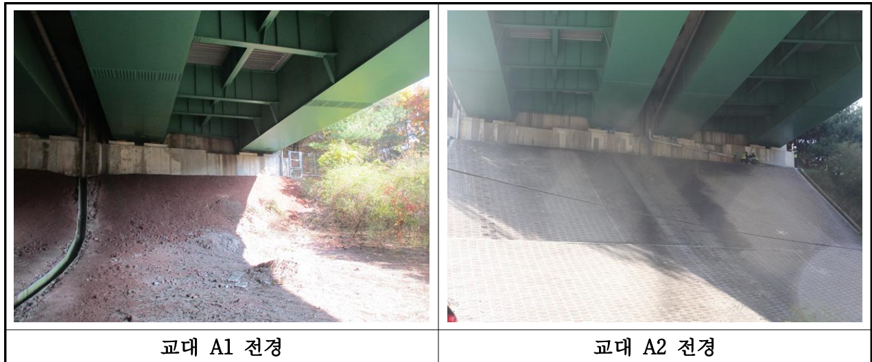
【사진 3.8】 교대 전경
