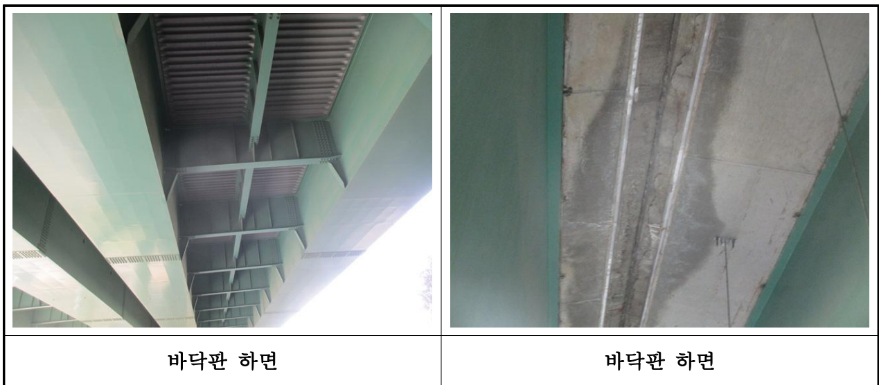
【사진 3.22】 바닥판 전경
