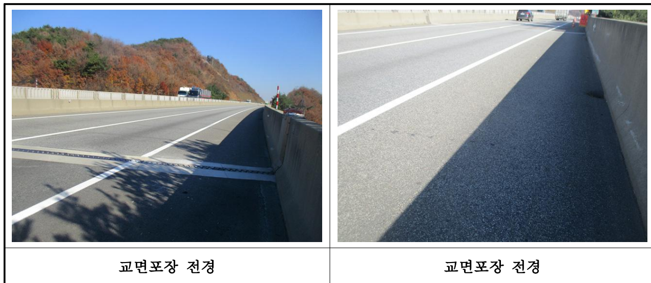
【사진 3.17】 교면포장 전경
